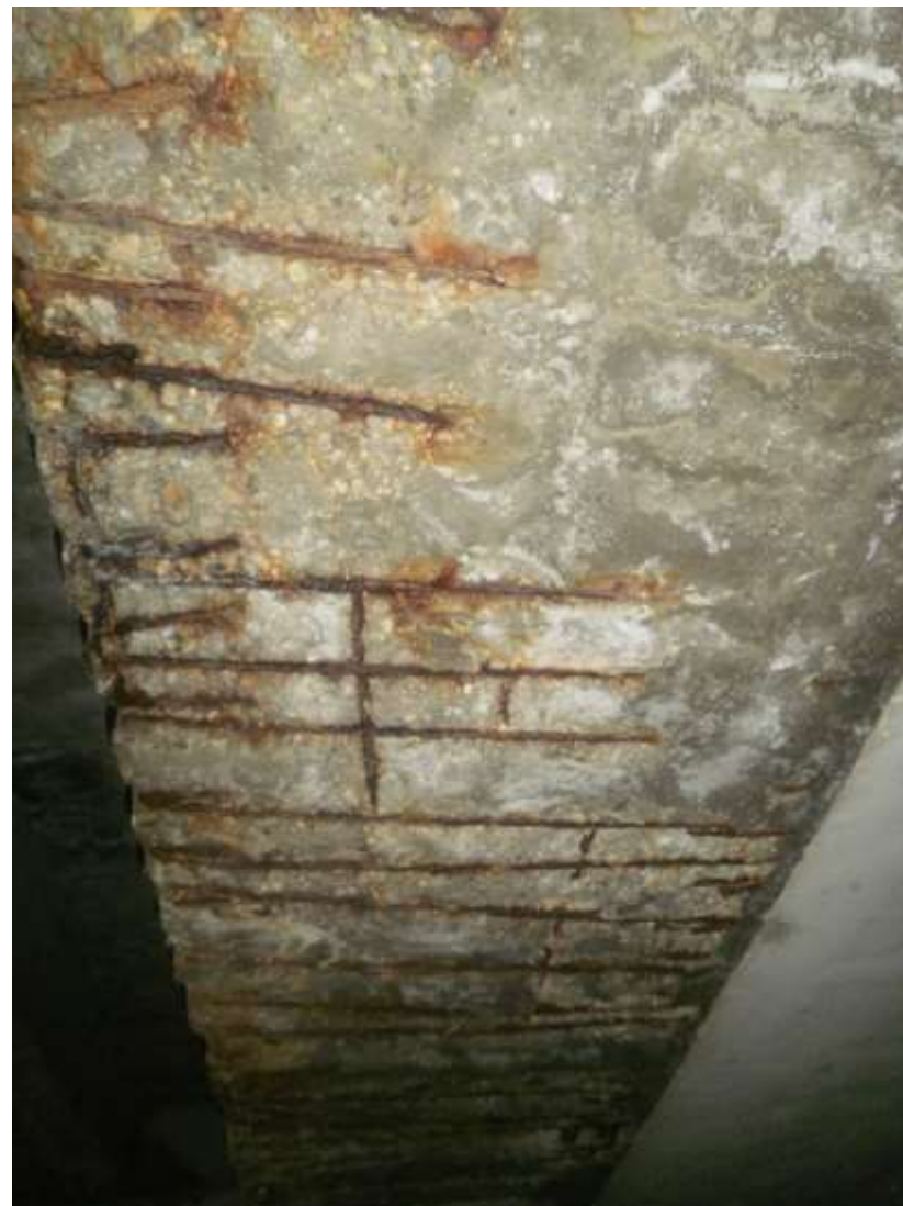
Obr. 2 Pohľad na spodnú časť nosníka mostovky
