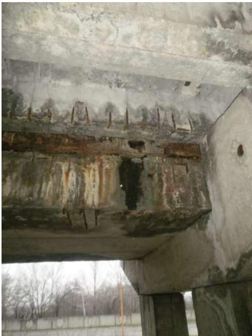
Obr. 1 Pohľad na uloženie nosníka mostovky na úložný prah piliera
