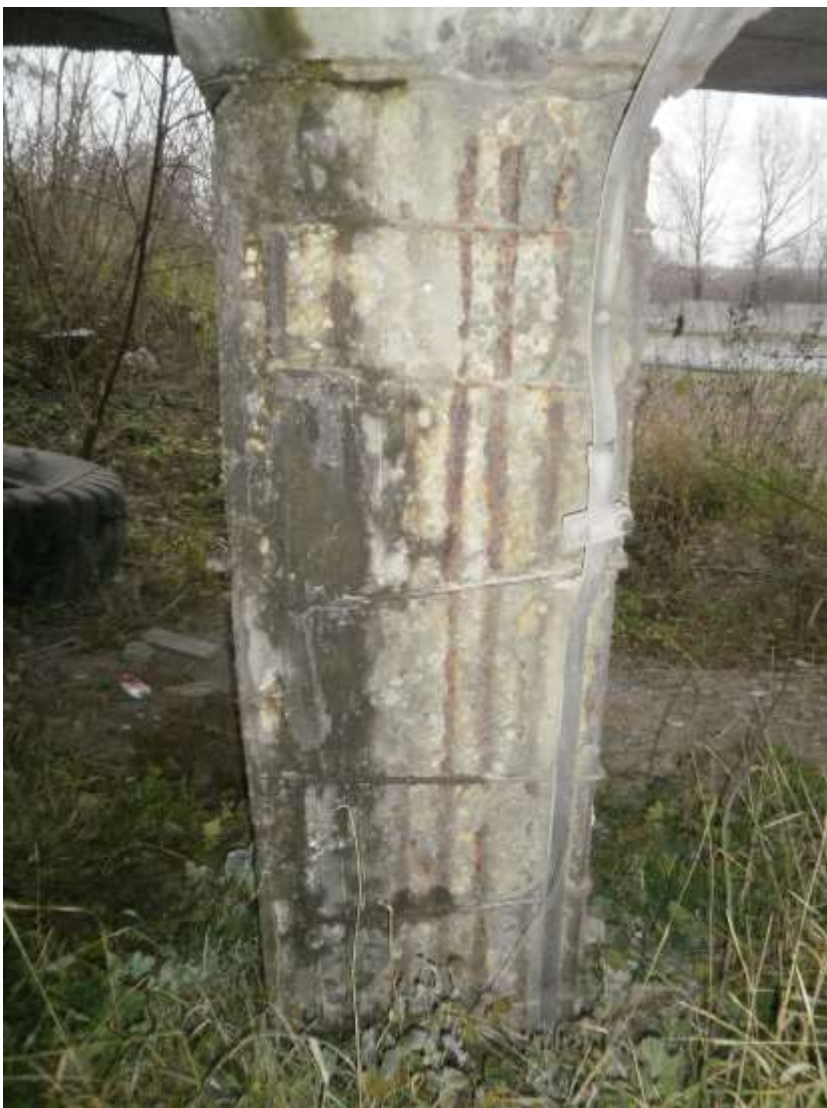
Obr. 3 Pohľad na súčasný stav drieku – stĺpa piliera
