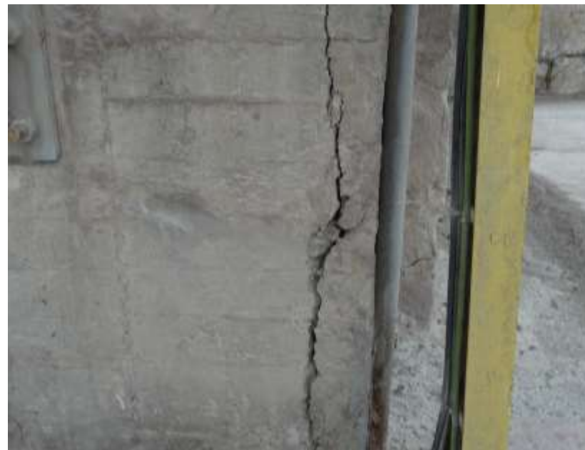
Obr. 10 Detail porúch nárožia JZ
