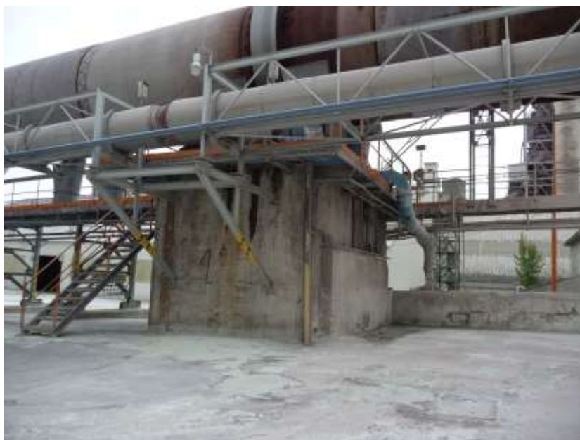
Obr. 9 Celkový pohľad na základ Z2
