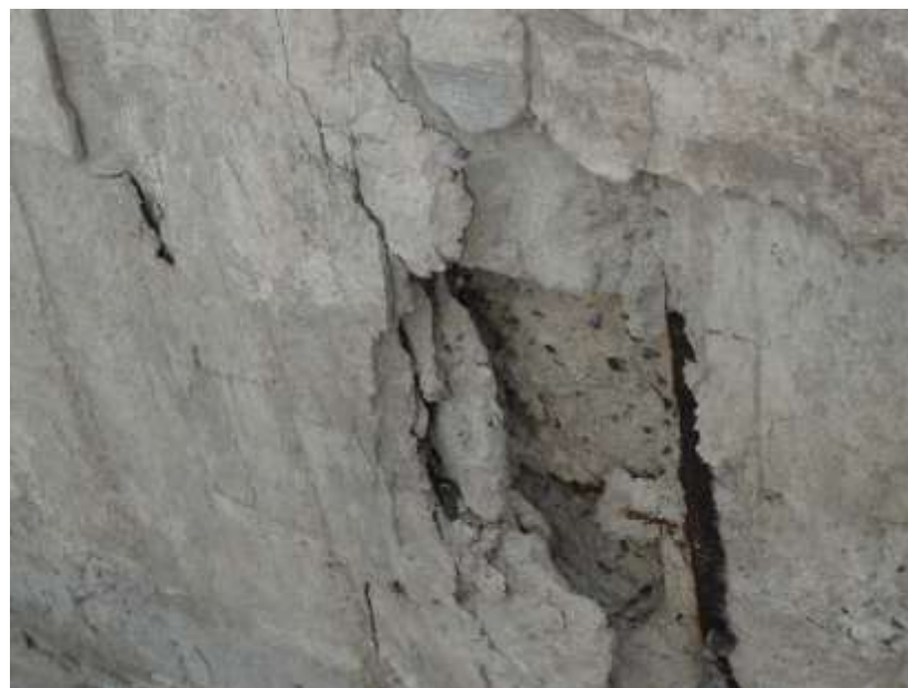
Obr. 8 Detail plošného rozpadu steny
