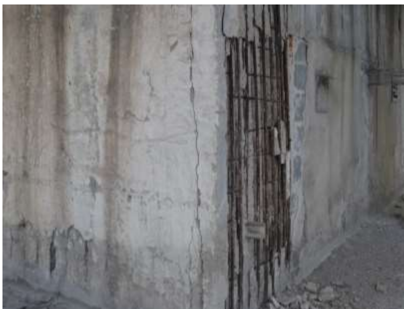
Obr. 3 Detail porúch náročia JZ
