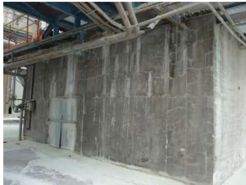
Obr. 18 Celkový pohľad na základ Z3 zo severnej strany
