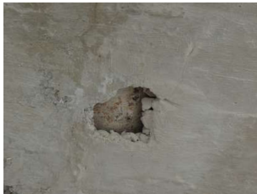
Obr. 20 Mechanická porucha základu Z3
