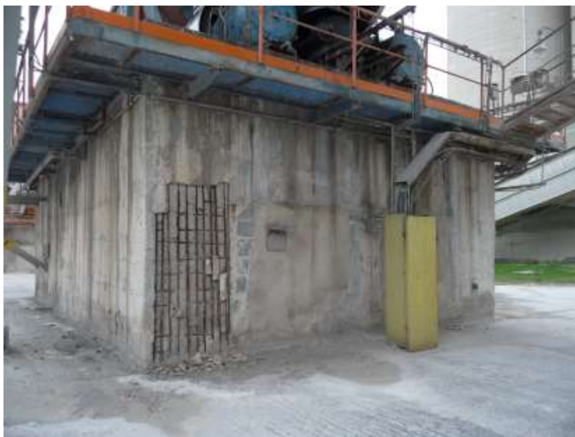
Obr. 1 Pohľad na základ Z1 z južnej strany
