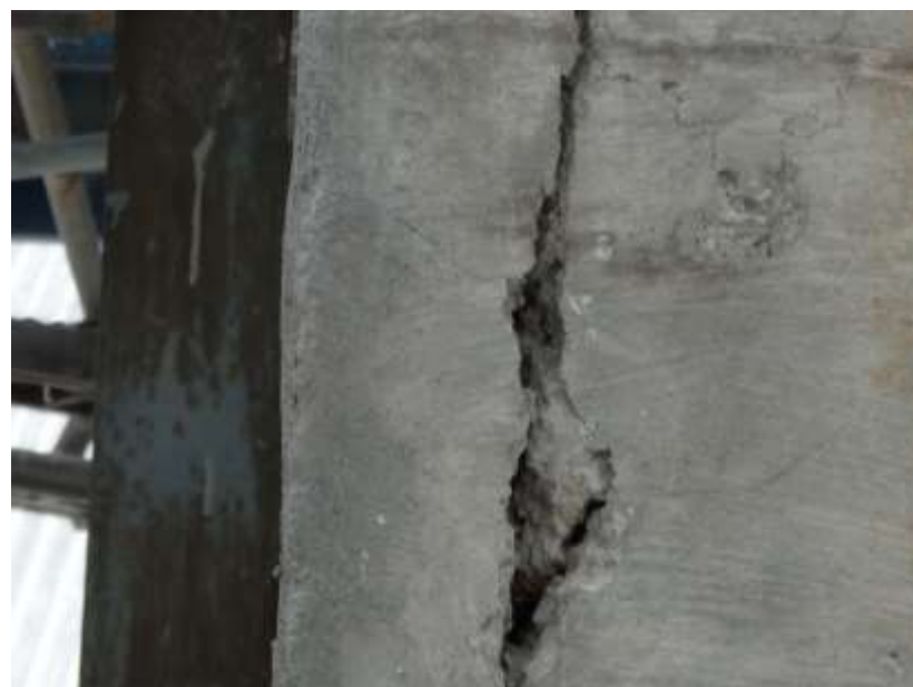
Obr. 12 Detail porúch nárožia JV
